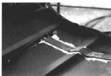
▲密らせるのと縦のラインに透き間ができるのでそこはパテなどで埋める。裏には補強のためのスチール板を入れて溶接とめ。
